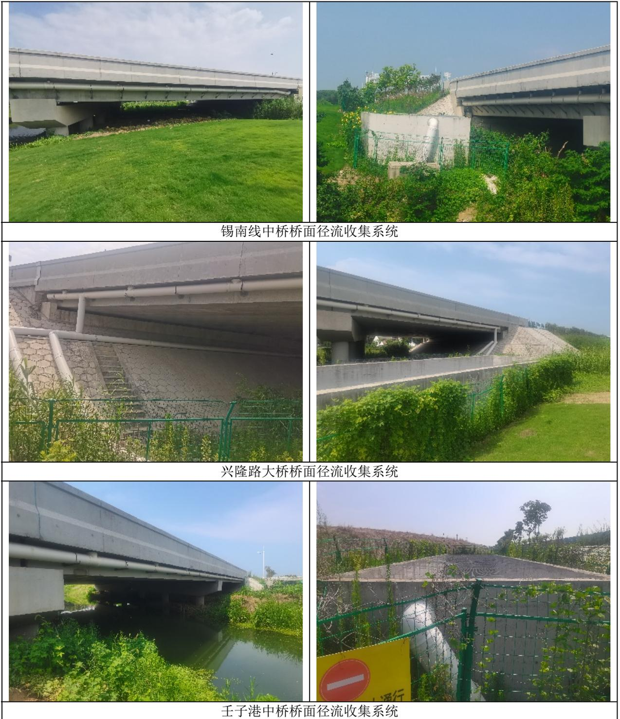
图 8.3-1 桥面径流收集系统现场照片
