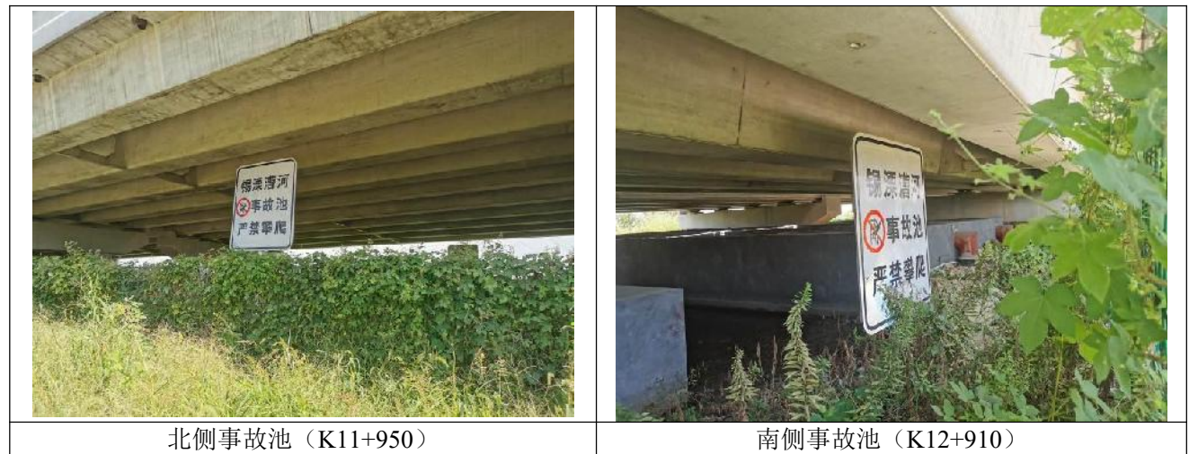
图 8.3-2 锡漂溇河特大桥桥面径流收集系统现场照片
