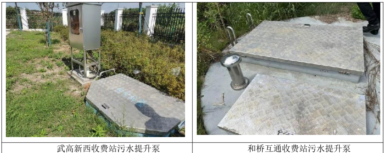
图 8.3-13 收费站生活污水提升泵
