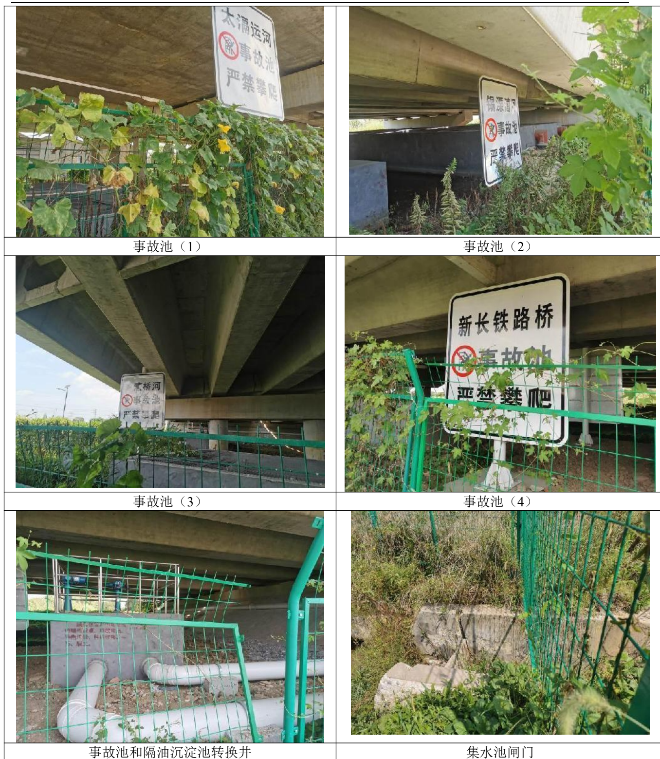
图 11.2-1 环境风险防范措施现场照片
