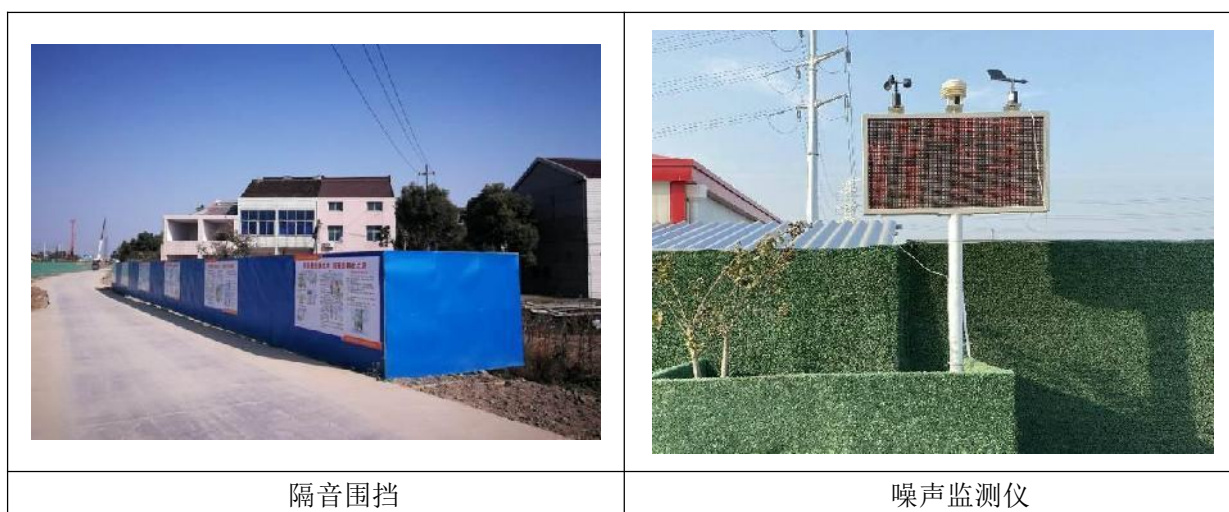
图 6.1-1 施工期噪声防治措施
