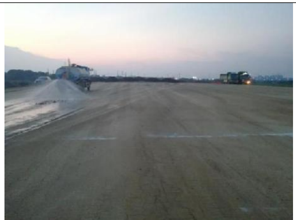
路基施工湿法抑尘
