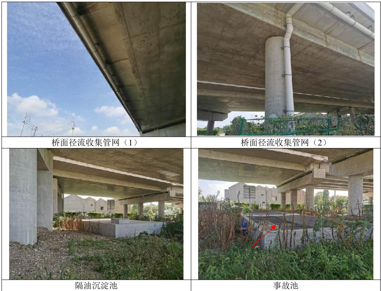
图 8.3-1 太滬运河大桥桥面径流收集系统现场照片
