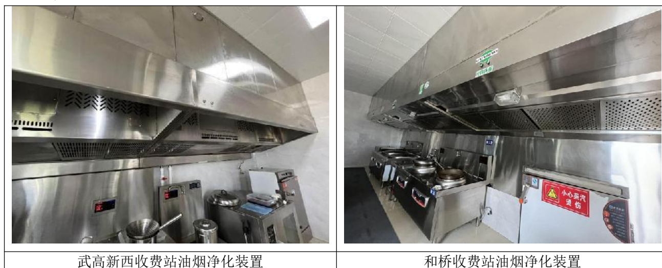
图 9.3-1 沿线收费站油烟净化装置
