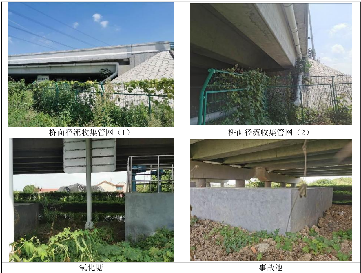
图 8.3-4 新长铁路大桥段桥面径流收集系统现场照片
