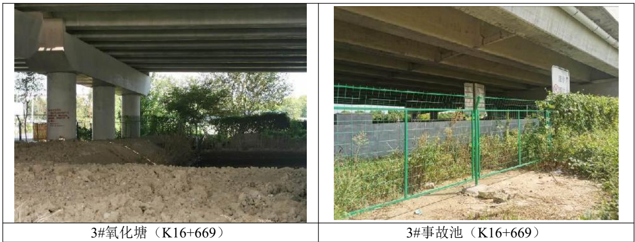
图 8.3-3 漕桥河特大桥桥面径流收集系统现场照片
