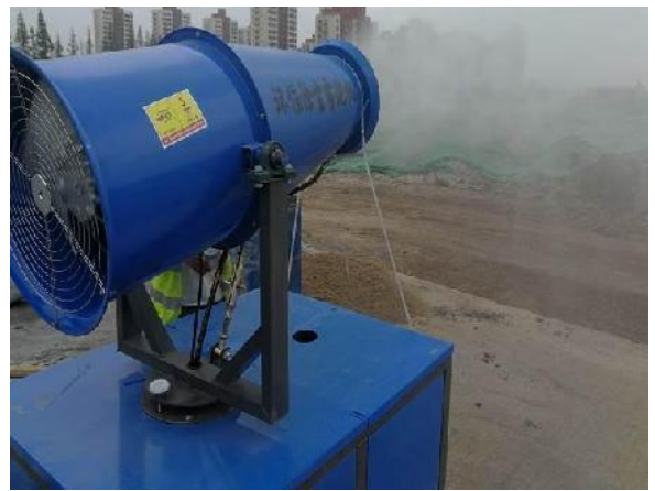
施工现场喷雾洒水
