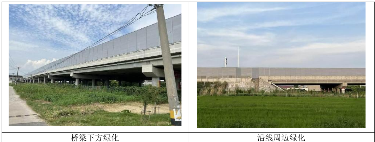
图 9.3-2 项目沿线绿化工程现状
