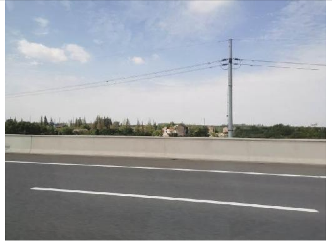
桥梁段防撞护栏
