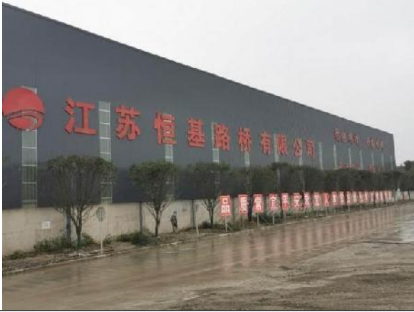
施工场地绿化
