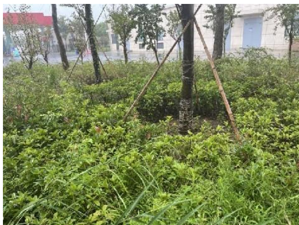
服务区化粪池
