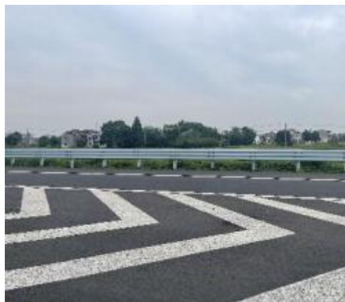
路基段防撞梁
