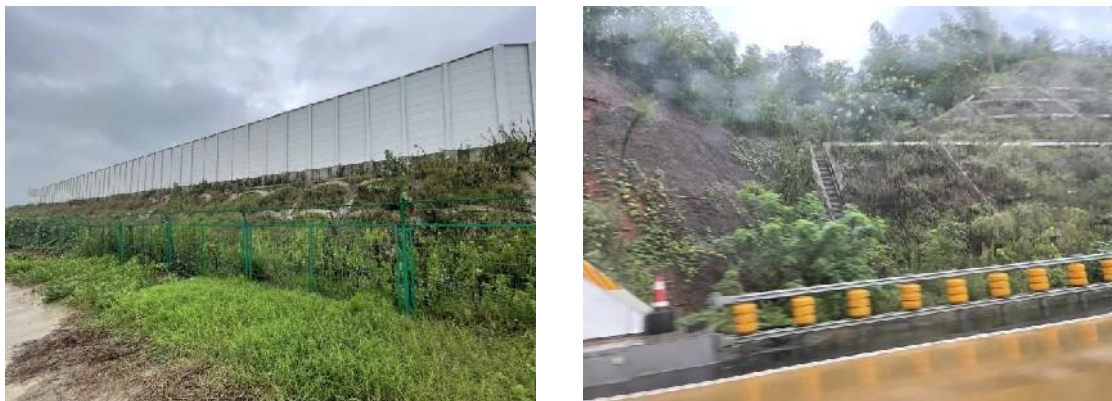
图 5.3-1 边坡防护现状照片
