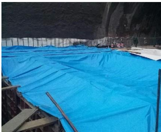
隧道口防尘防污染用彩条布遮盖
