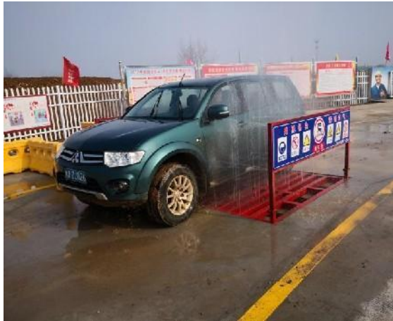
运输车辆设置清洗装置
