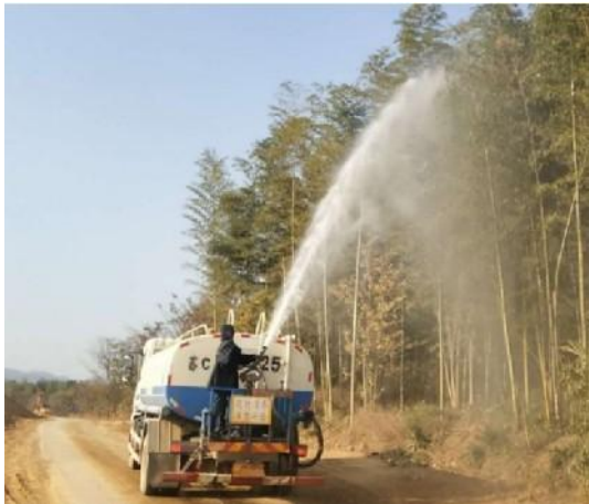
施工现场周围洒水降尘
