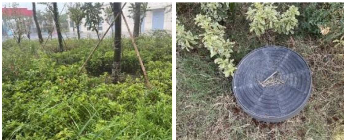
服务区化粪池
