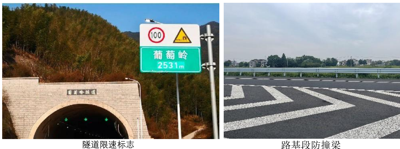
图 11.1-1 环境风险防范措施现场照片
