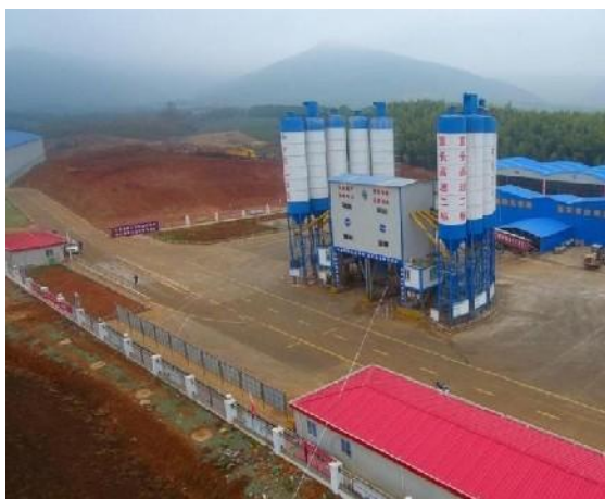
拌合站水泥储存罐顶增加防尘处理装置并配有洒水车降尘
