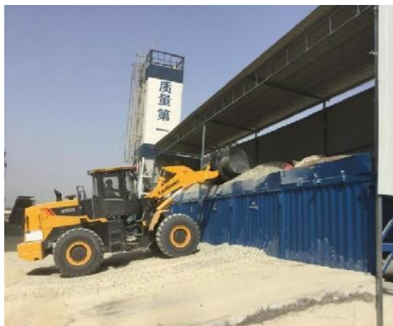
拌合站上料台、分料仓设置防尘大棚、防止粉尘扩散
