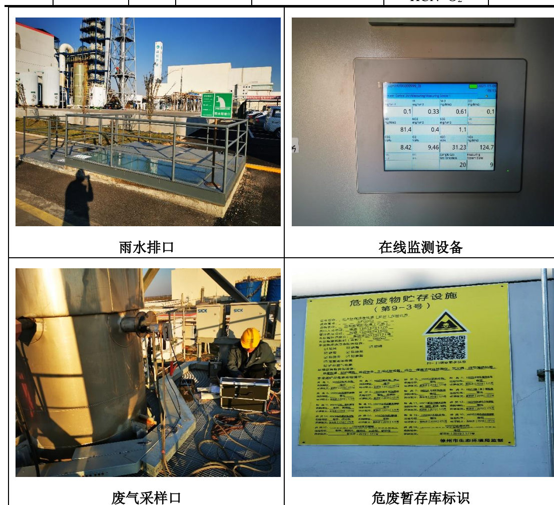
图 4.2-3 各排污口、标识现场情况
