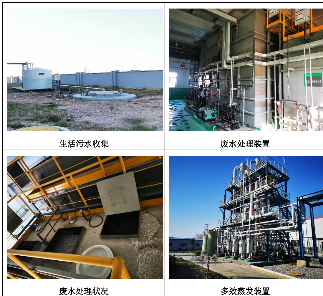
图 4.1-5 废水治理设施图
