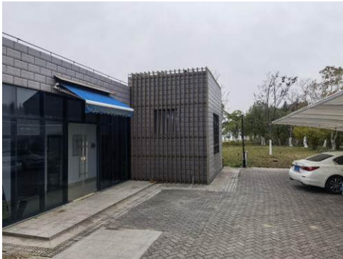
学院路闸管理站房
