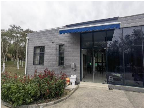
三船路闸管理站房
