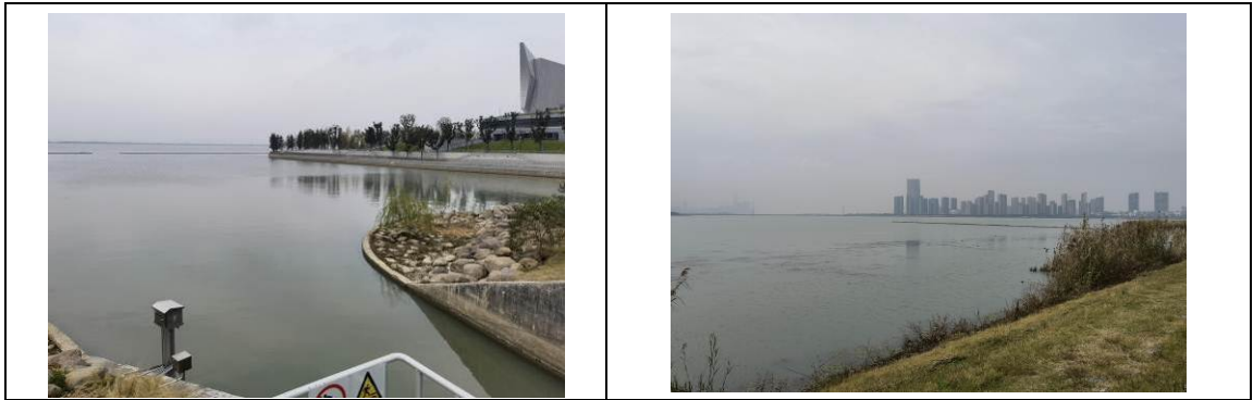
还湖大堤现状照片
