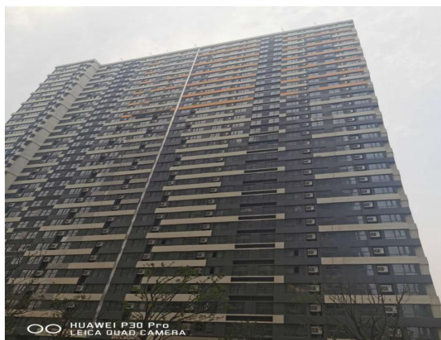
图 4.1-3 空调外机组照片
