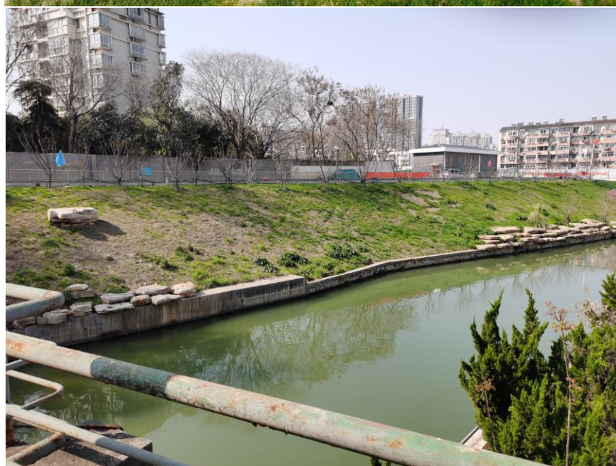
图 6-2 恢复现状情况
