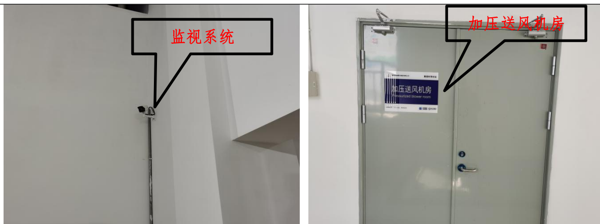
图 4-1 净水站工程现场照片
