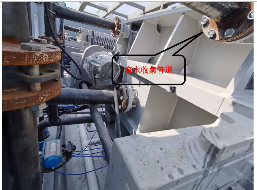
图 6-5 压滤机房的废水收集系统
