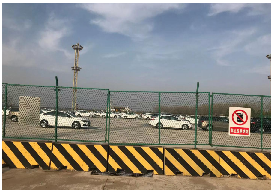
图 3.4-1 存车场现场照片
