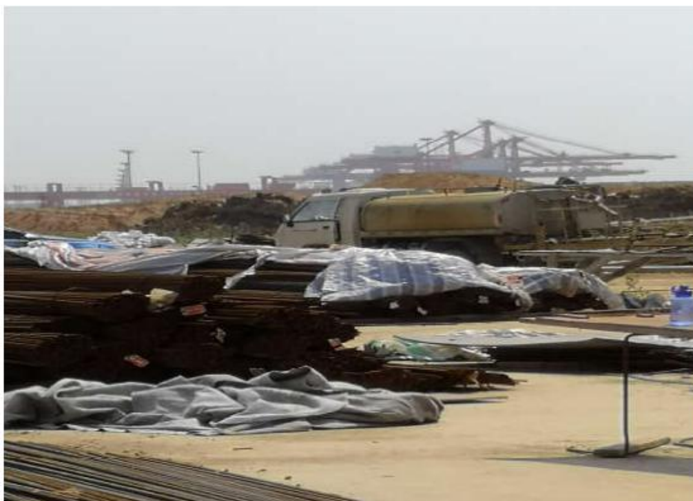
图 6.1-1 施工材料集中堆放、洒水车除尘
