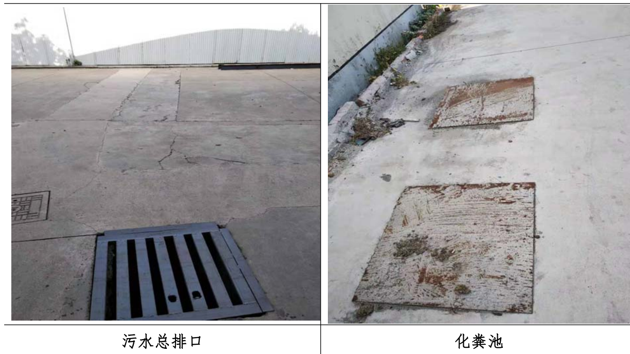
图 4-2 废水治理设施
