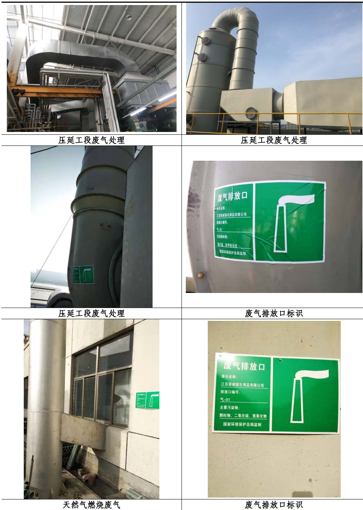
图4-4 废气治理设施图
