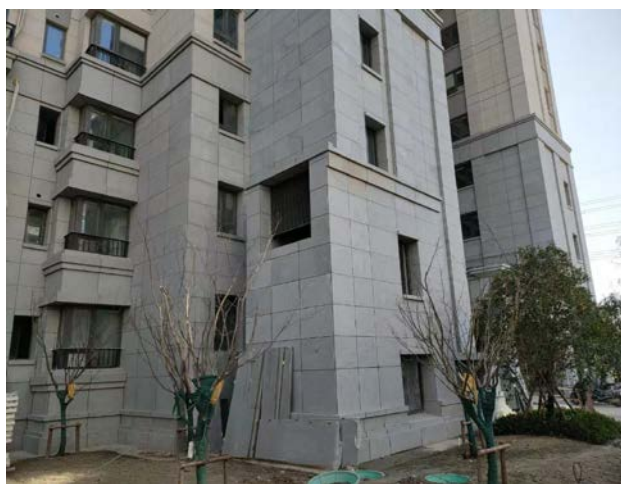
图4-4 地下车库排气口
