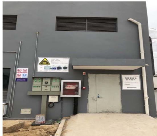
危险废物暂存场所
