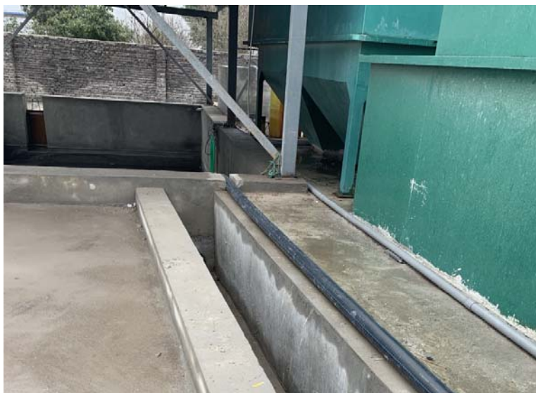
图 4-3 现有污水站及明渠
