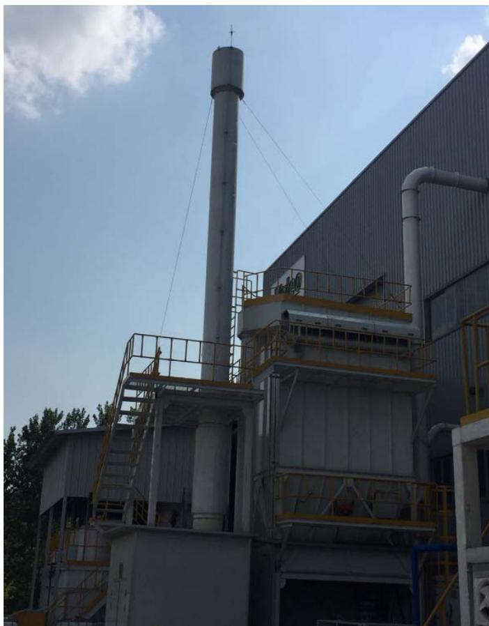
图 4.2-4 布袋除尘器及配套排气筒
