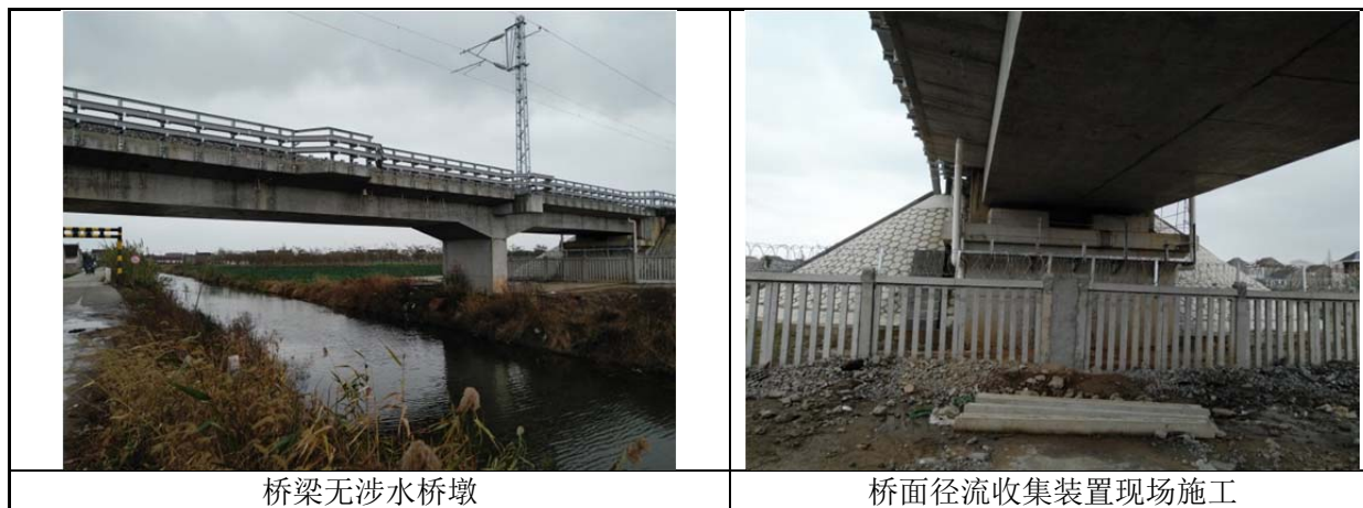
图 10.6-7 清水通道维护区环保措施落实情况
