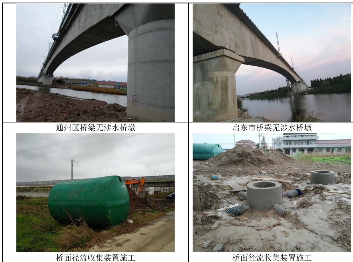
图 10.6-3 清水通道维护区环保措施落实情况
