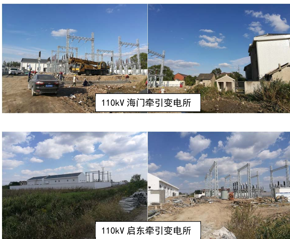
图 11.1-1 变电所现场照片
