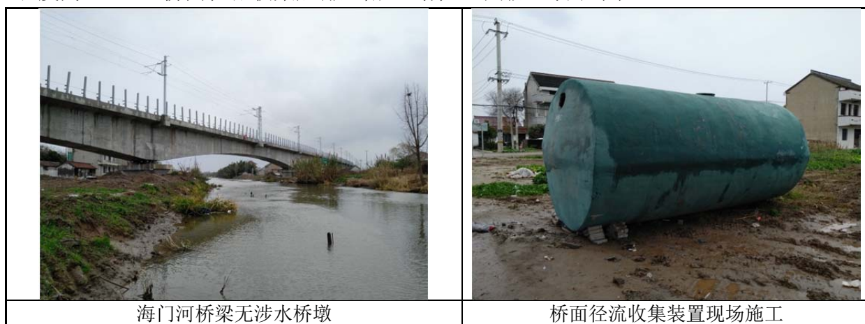
图 10.6-5 清水通道维护区环保措施落实情况
