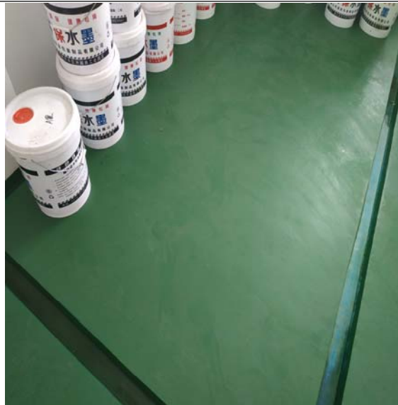
危废暂存场所地面防渗
