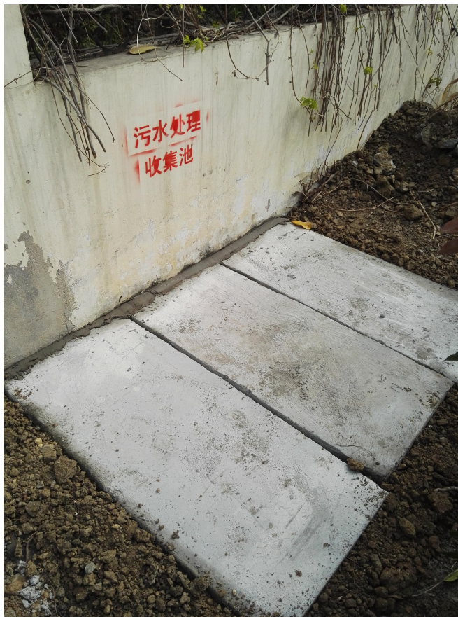
图 3.3-3 门站内化粪池设置情况
