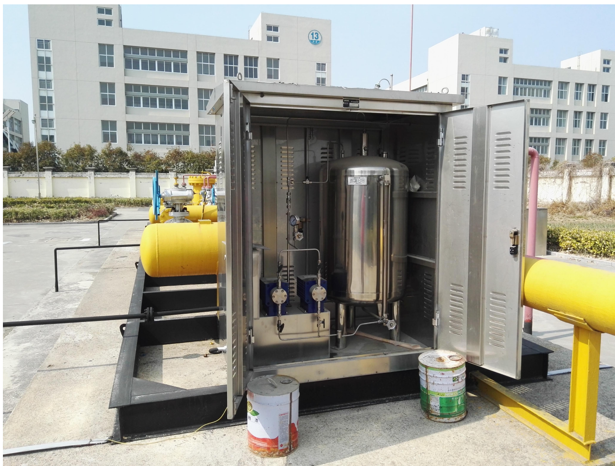
图 3.3-2 加臭剂四氢噻吩储存情况
