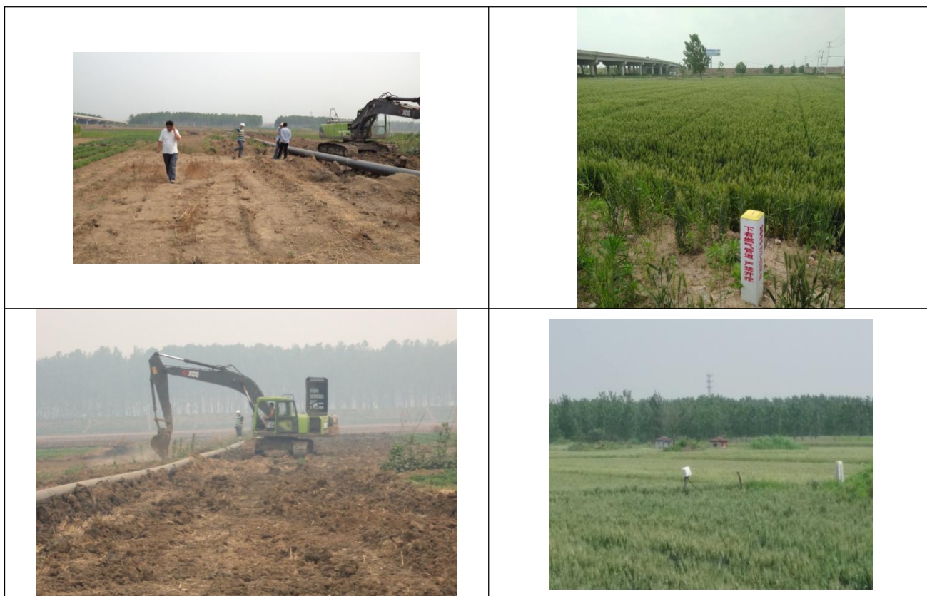
图 3.3-1 施工期间开挖及恢复后的对比情况图
