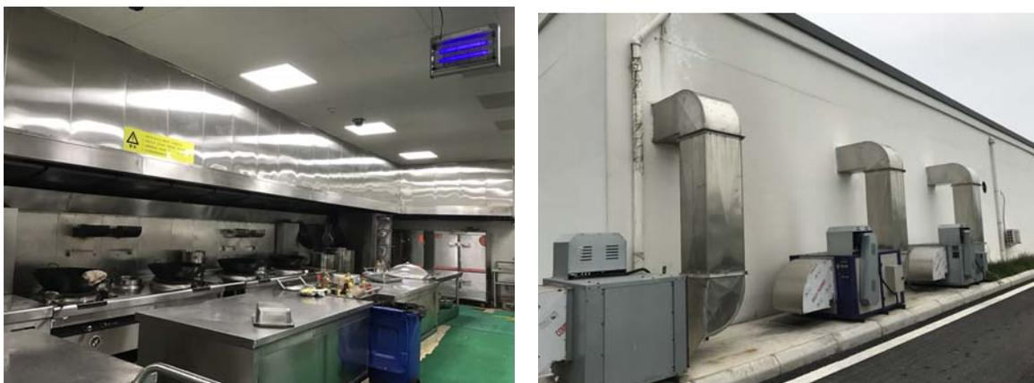
图 7.2-1 油烟净化装置
