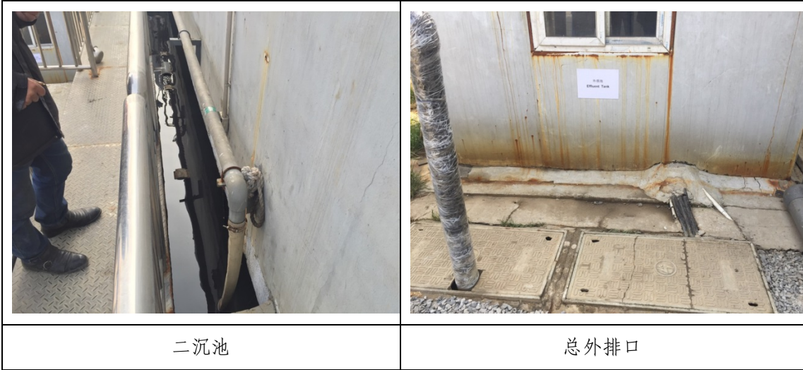
图 4-1 废水治理设施
