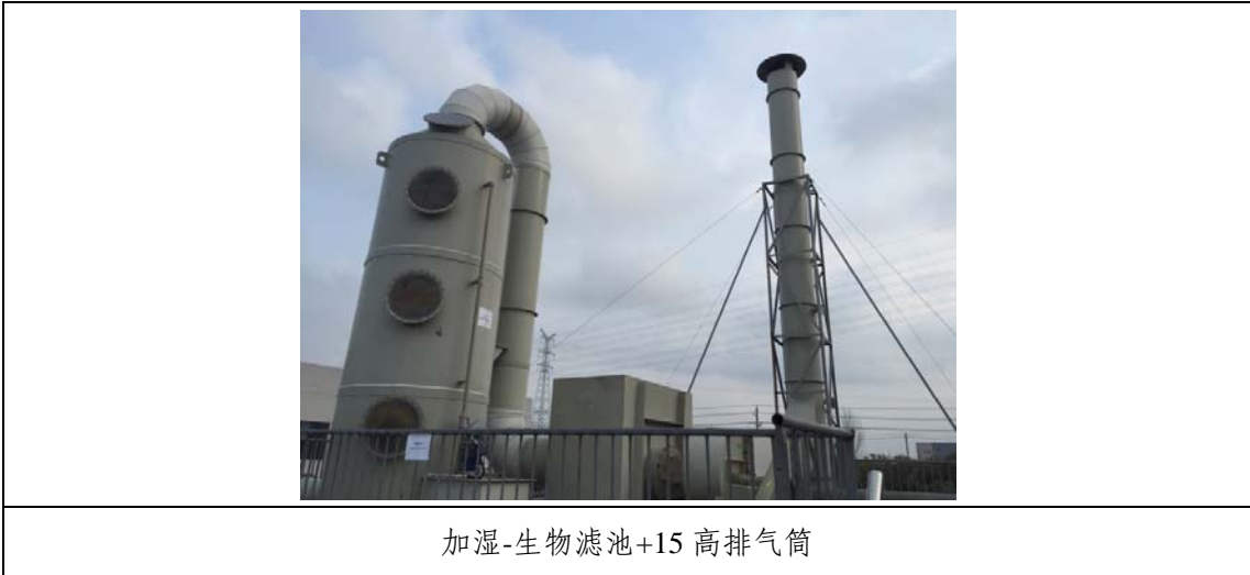
图 4-2 废气治理设施
