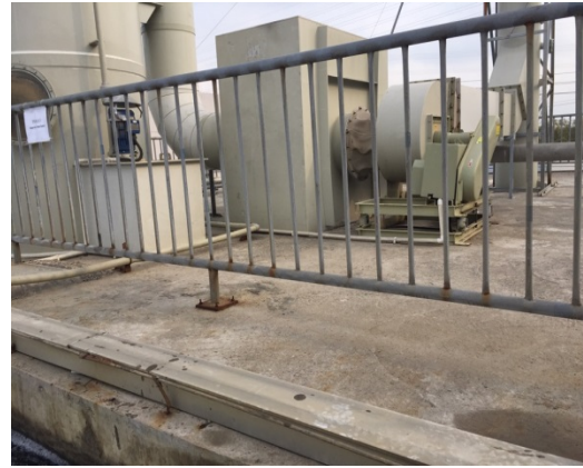
厌氧池（封闭的）
