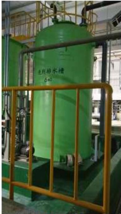
图 4.2-1 洗剂排水槽
