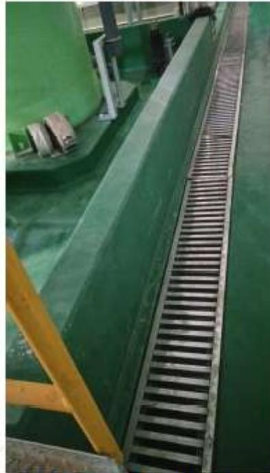
图 4.2-2 洗剂排水槽设置围堰与导流槽
