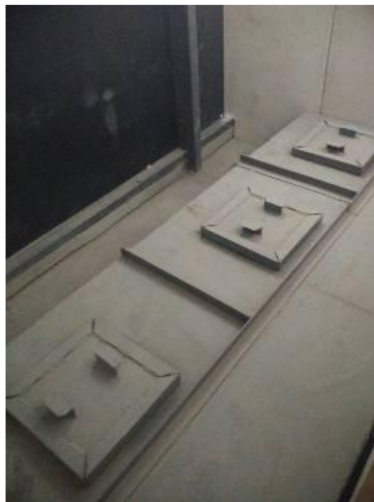
图 4-3 餐饮隔油设施现场图片
