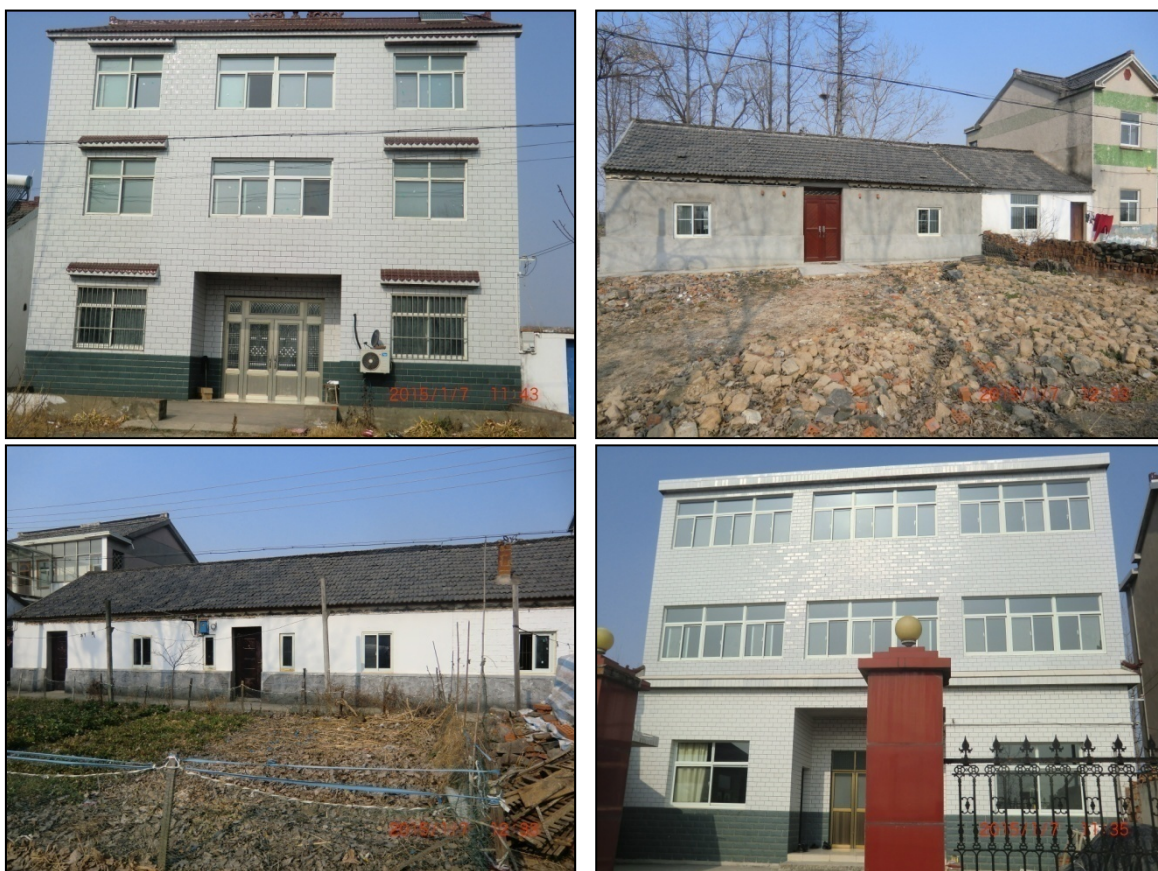
图 6.4-1 本工程隔声窗实施现状
