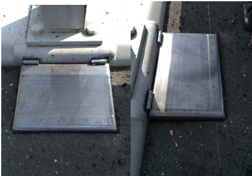
图 9.2-1a 泄水孔封盖现场照片
