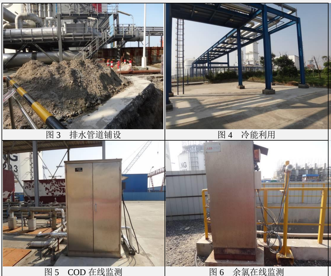
图 4.2-1 厂区废水处理系统建设情况
