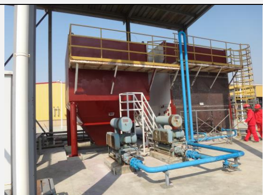
图 2 检查废水处理装置运行情况
