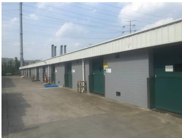
危废贮存仓库
