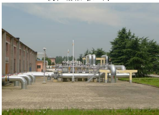
站内工艺区水泥硬化
