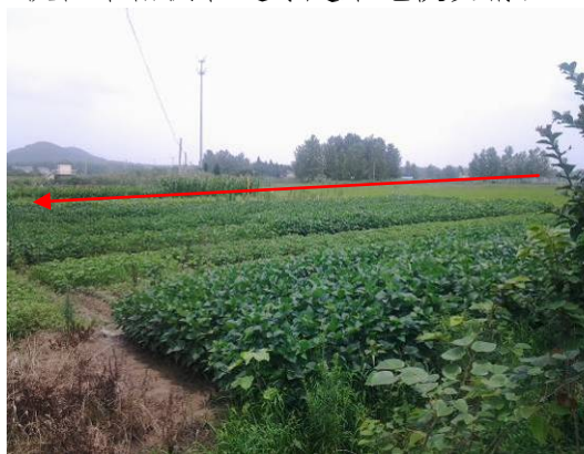
仪征站南侧管道穿越菜地恢复情况
