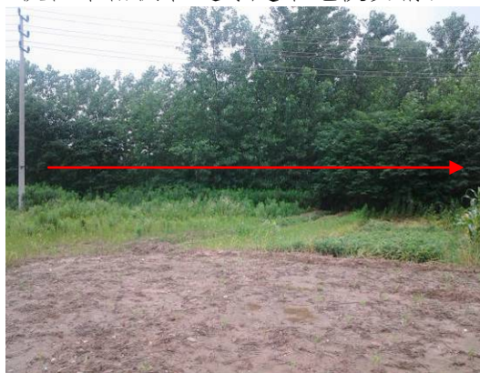
管道穿越林地恢复情况
