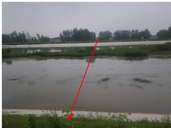
滁河穿越处恢复情况
