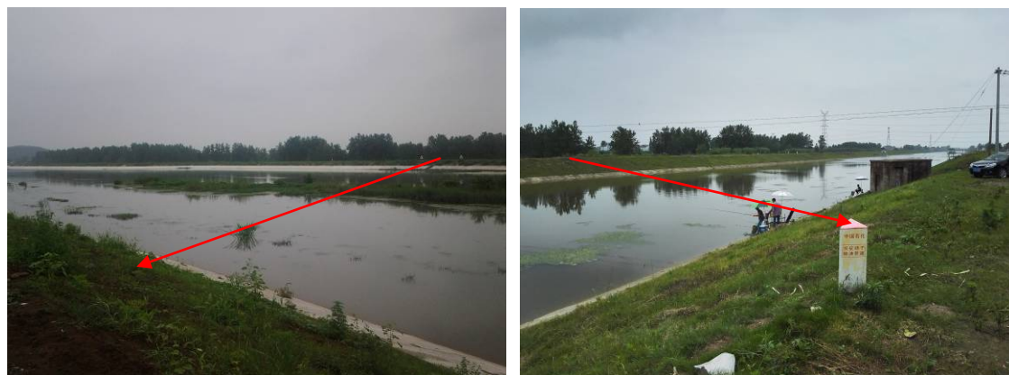
滁河穿越处两侧护坡
