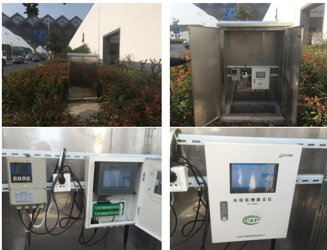
图 8.3-1 废水排口现场勘查照片
