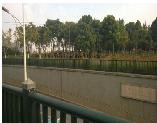
图 5.4-3 人民路铁路立交桥绿化
