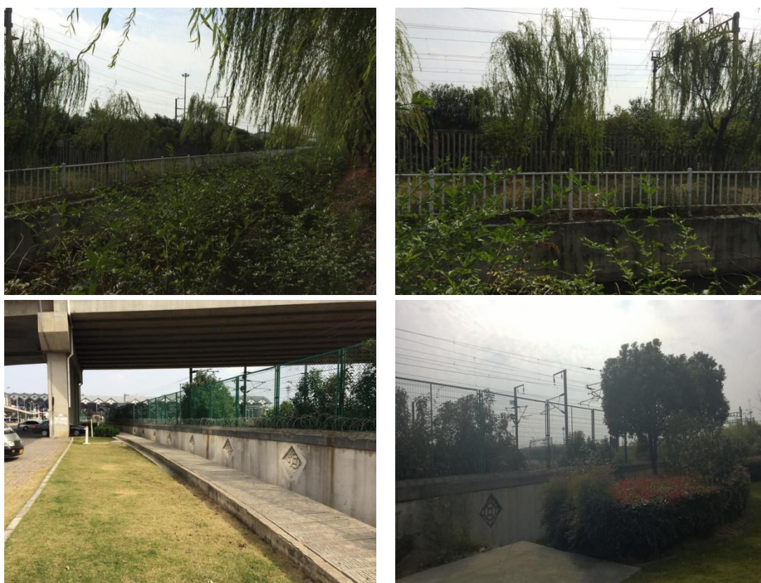
图 6.3-2 铁路沿线降噪措施照片
