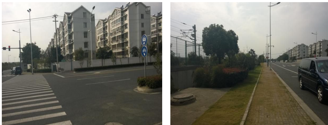
图 6.3-1 新天地家园小区降噪措施照片
