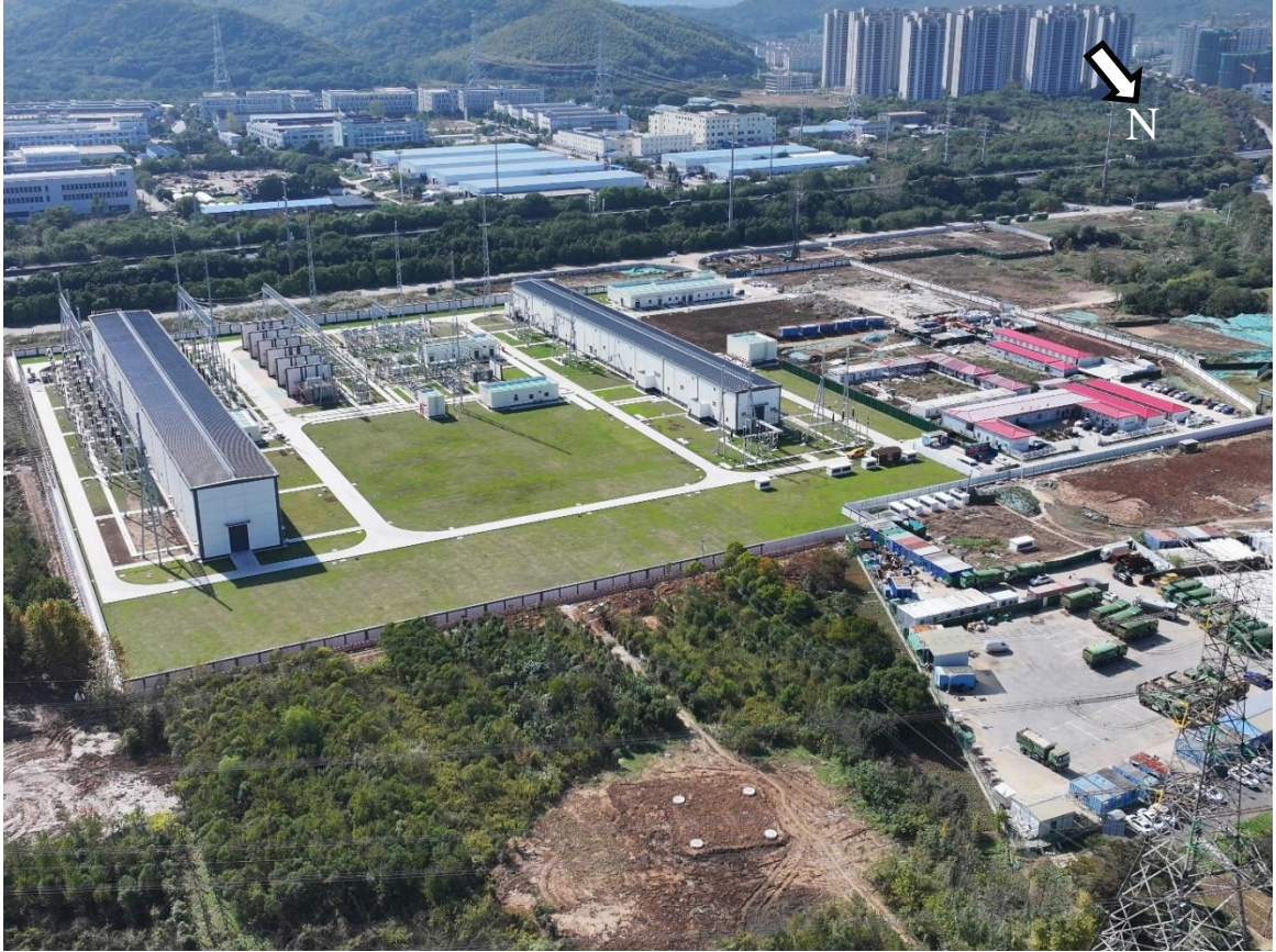
新东善桥站址现状
