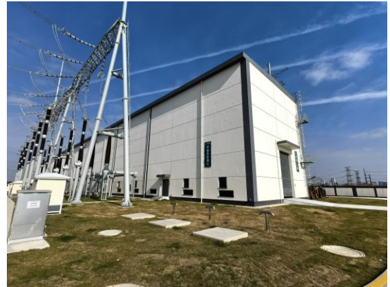
2#主变事故油池
