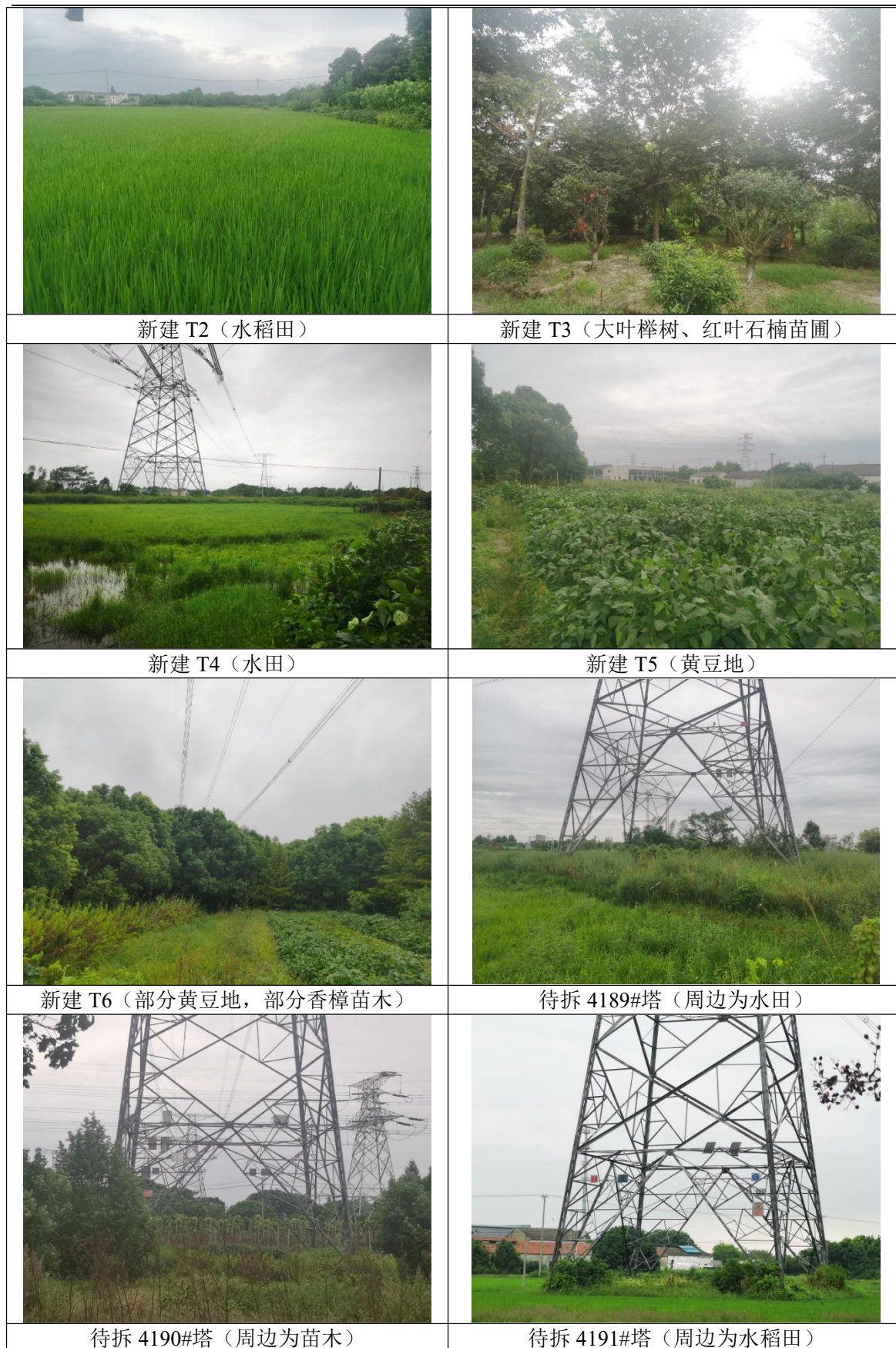
图 5.1-1 新建塔基及拆除塔基处现状照片
