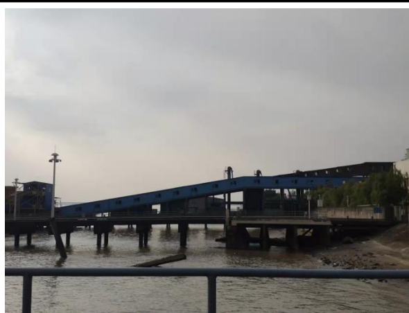
封闭式输煤管廊
