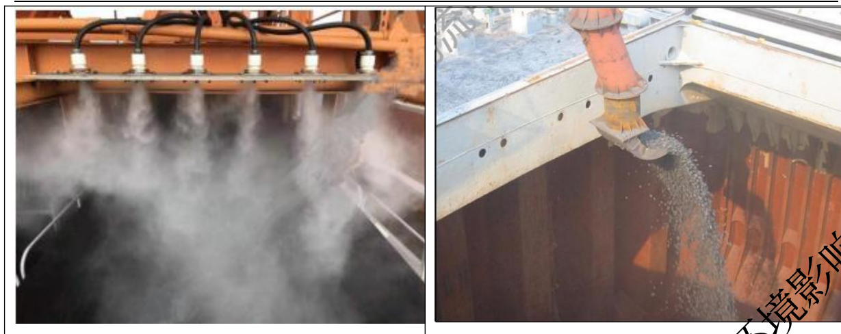
图 7.1-2 前沿喷淋抑尘、装船机控制作业高度示例图
