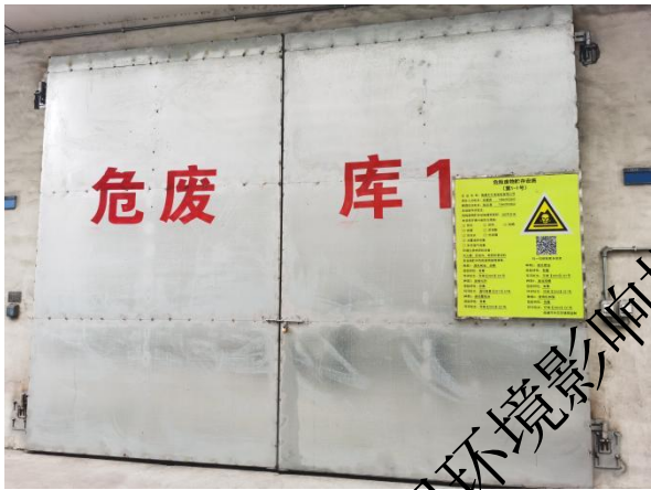
危险废物暂存库
