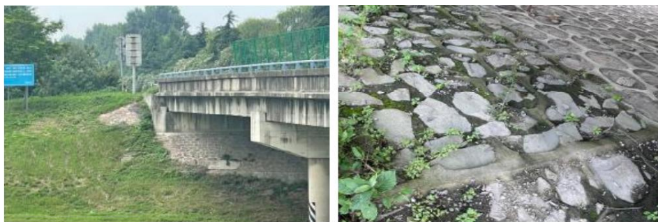
图 2.2-4 老路利用改造段边坡防护
