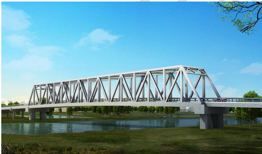
图 2.3-4 钢桁架梁桥示意图
