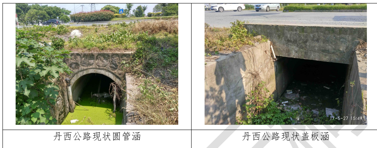
图 2.2-9 沿线涵洞现状
