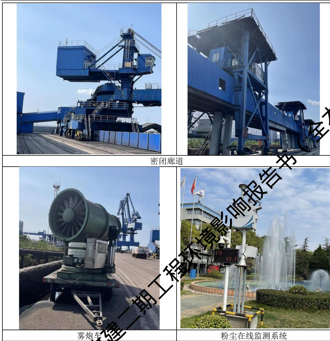
图 4-5-7 废气污染防治设施现场照片
