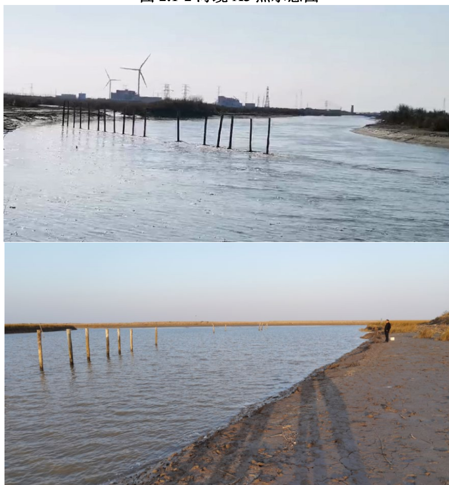
图 2.1-3 川水港闸下游入海水道区段现状图（上图木桩左侧,下图木桩右侧）
