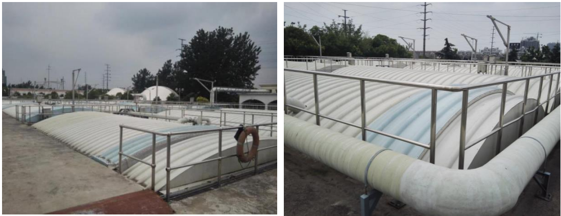
图 7.2.1-3 同类型污水处理厂装置密封示意图
