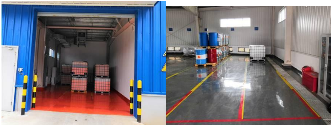
图 7.4-1 二厂区危废库
