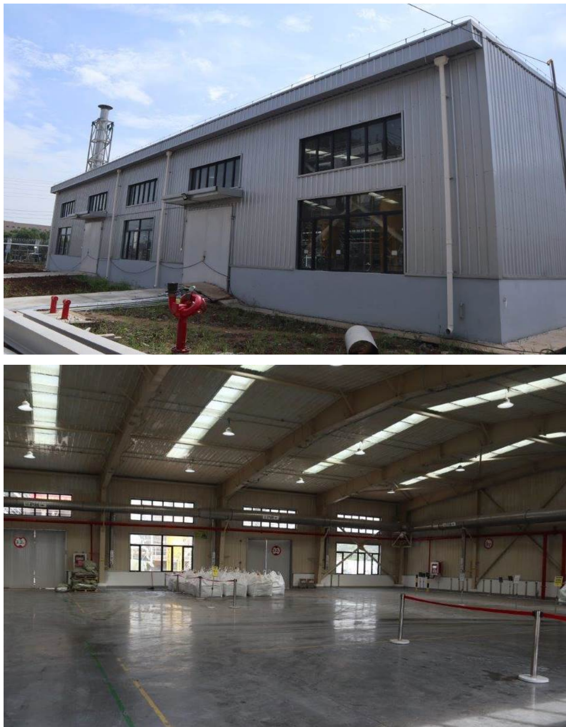
图 3.4.2-3 现有危废堆场照片
