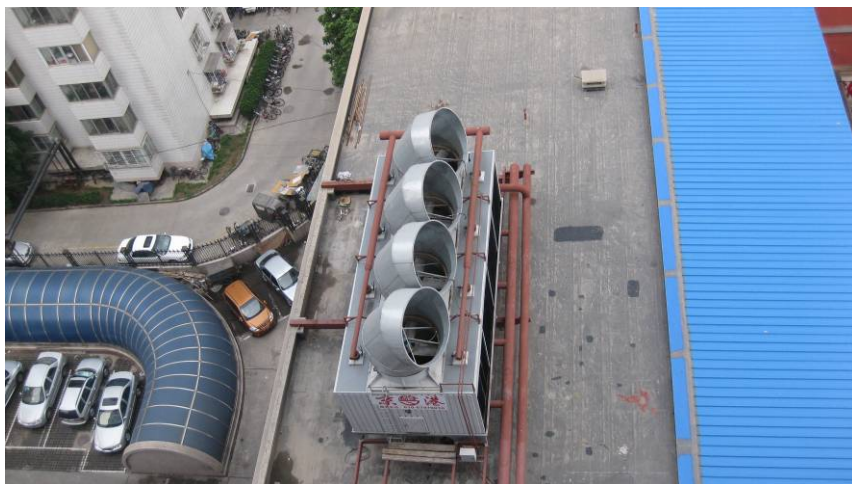
图 5.1-1 冷却塔导向消声器实施实例
