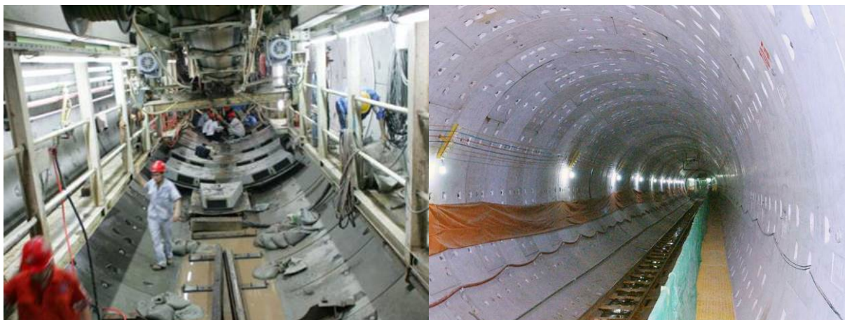
盾构法隧道内部施工现场
