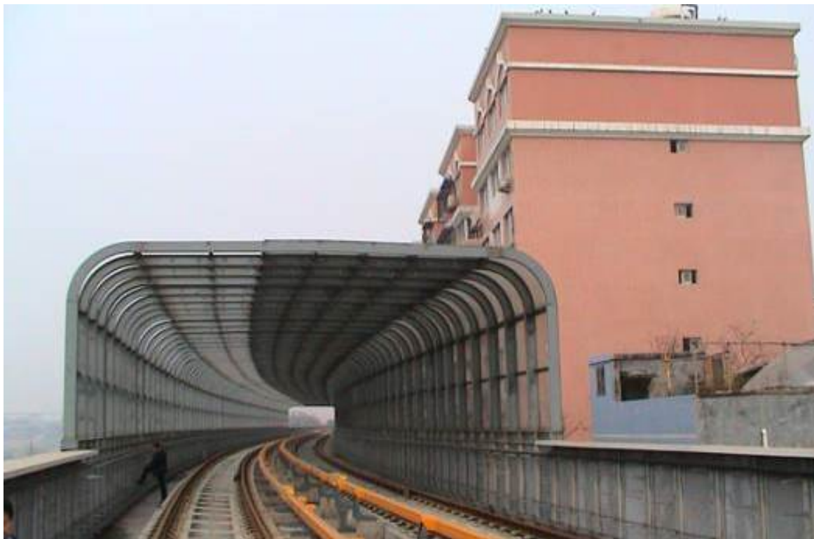
图 5.1-3 大型折板式（半封闭）声屏障示意图
