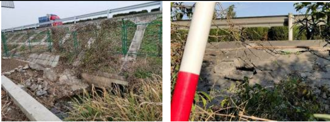
图 2.1-2 京沪高速公路广陵至靖江段路基边坡防护现状
