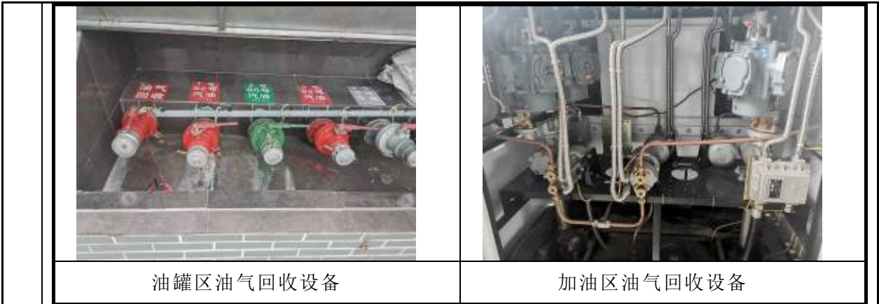
图 2.1-6 现状服务区加油站照片
