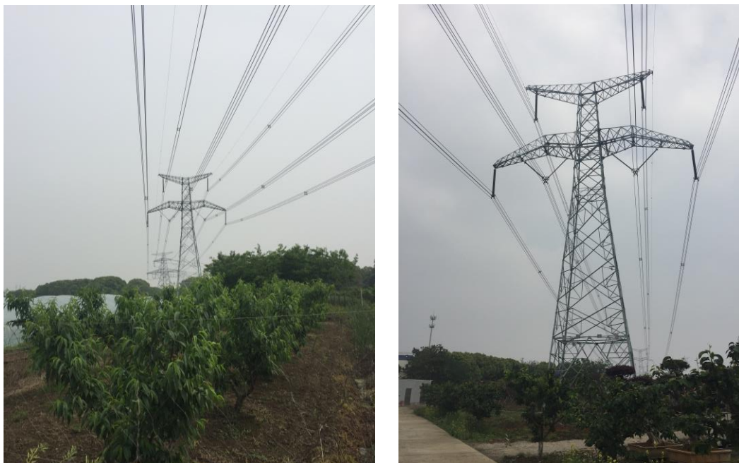
图 4.2-1 本工程输电线路沿线现状周围情况
