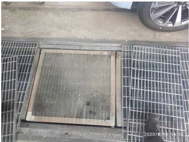
总装补漆室过滤袋
