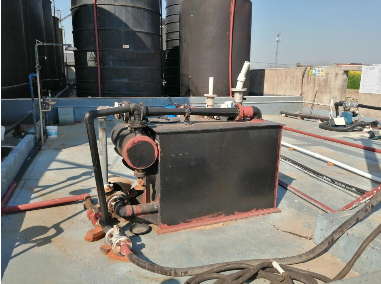
图7.1-2水喷射真空废气吸收器示意图
