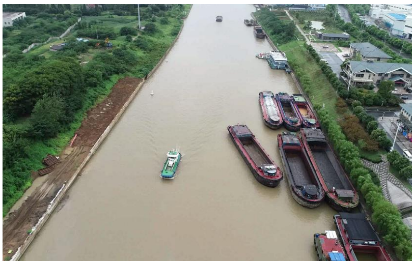
图 2.1-7 京杭运河江南城镇段绿化缺损段现状图（镇江）
