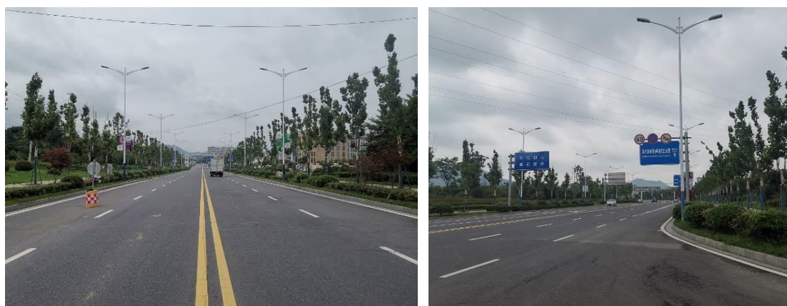
图 1.2-2 五华路路面现状
