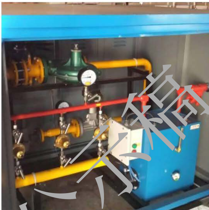
图 3.7.3.1 燃气减压装置示意图
