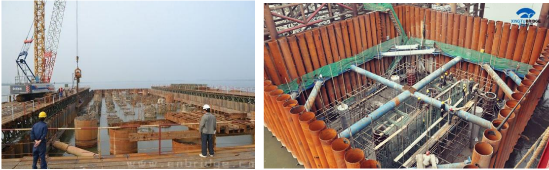
图 2-1-61 钢板桩围堰、钢管桩围堰施工
