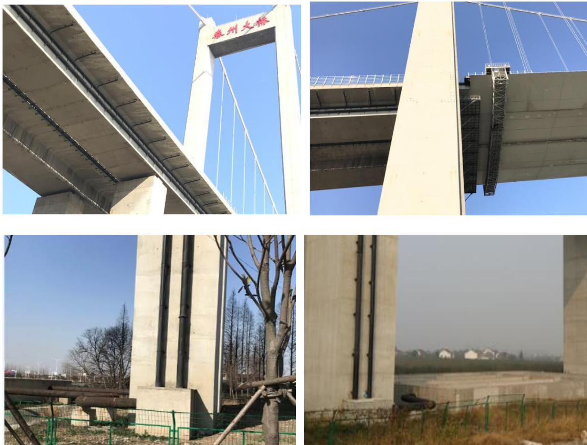
图 8-3-7 泰州长江公路大桥跨江段桥面径流收集现场图
