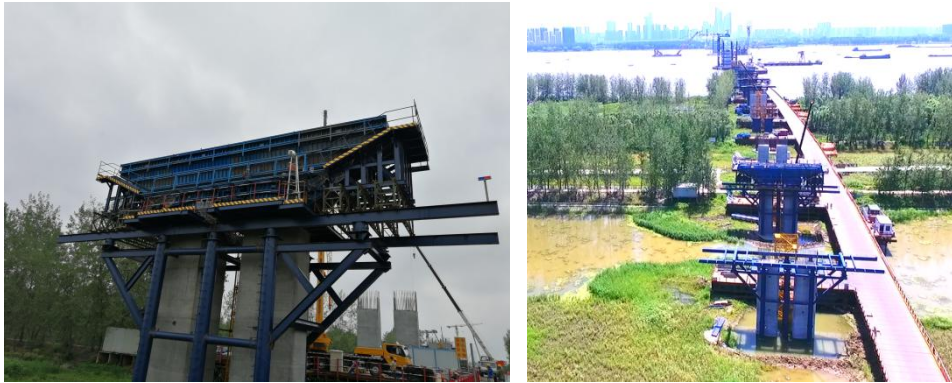
图 2-1-68 引桥基础及下部结构施工
