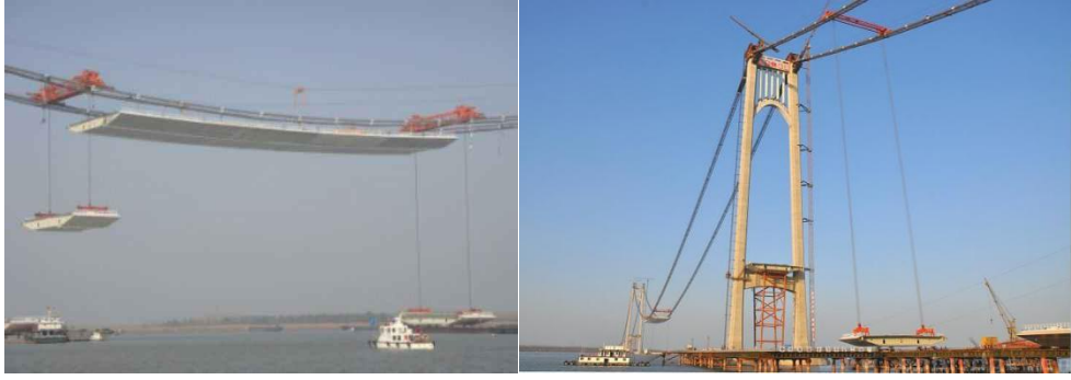
图 2-1-67 悬索桥钢箱梁吊装
