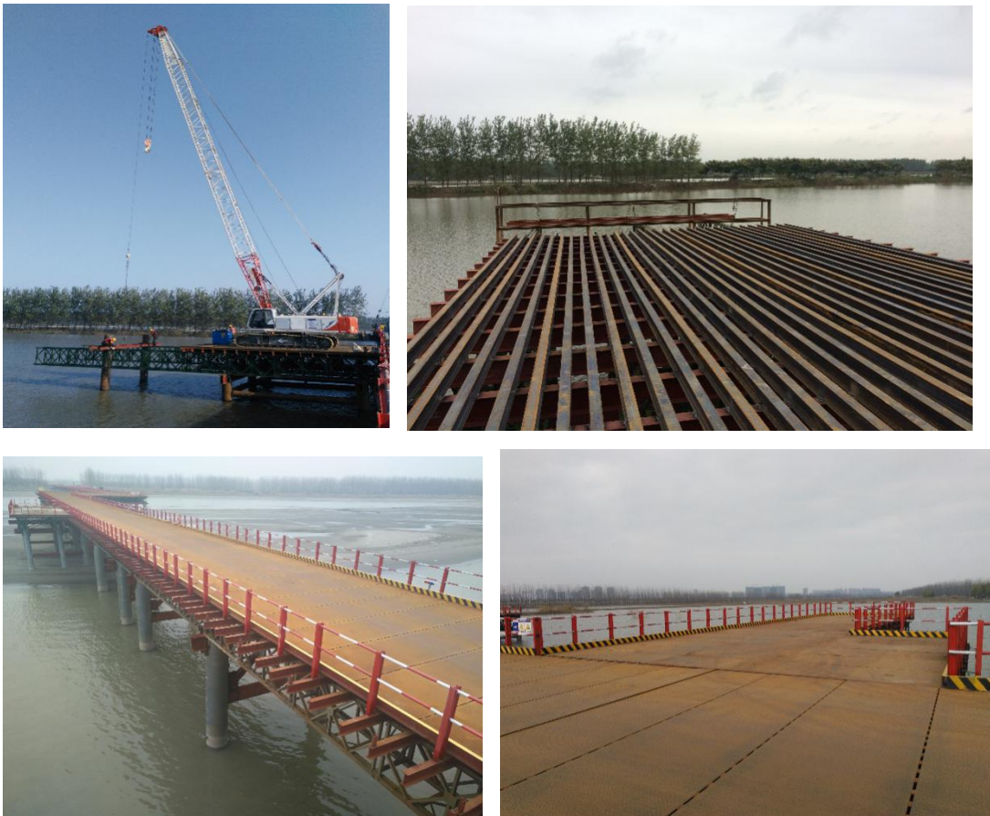
图 2-1-70 类似工程栈桥照片
