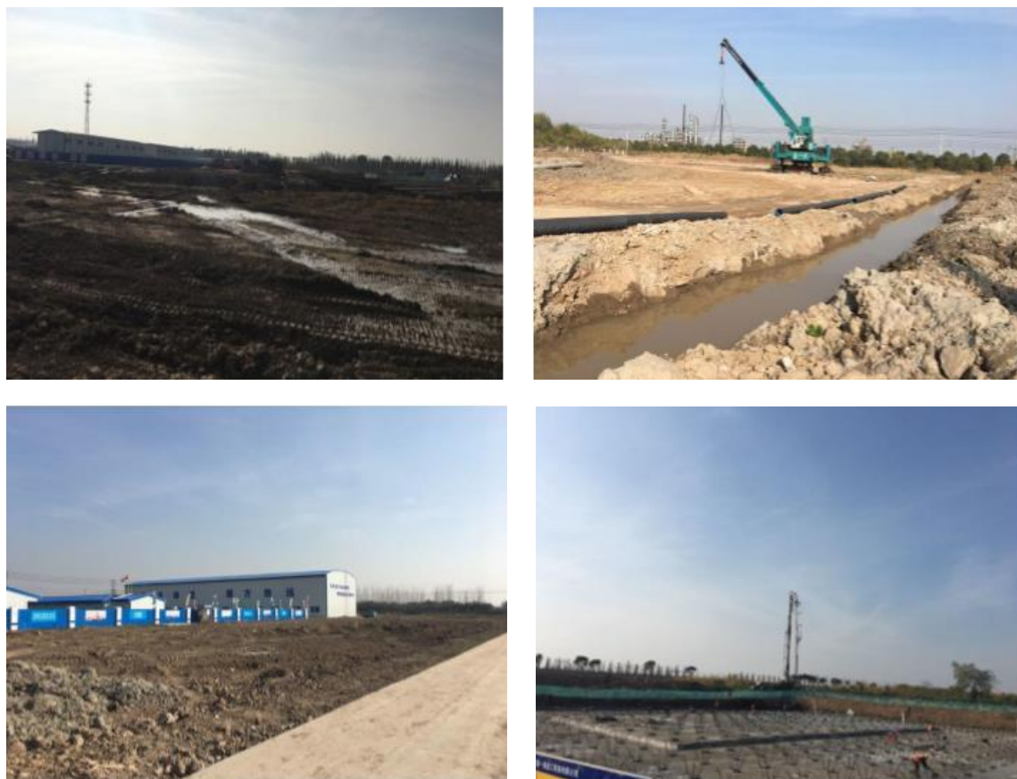
图 5.2-2 泰兴工业污水处理厂内场地现状照片
