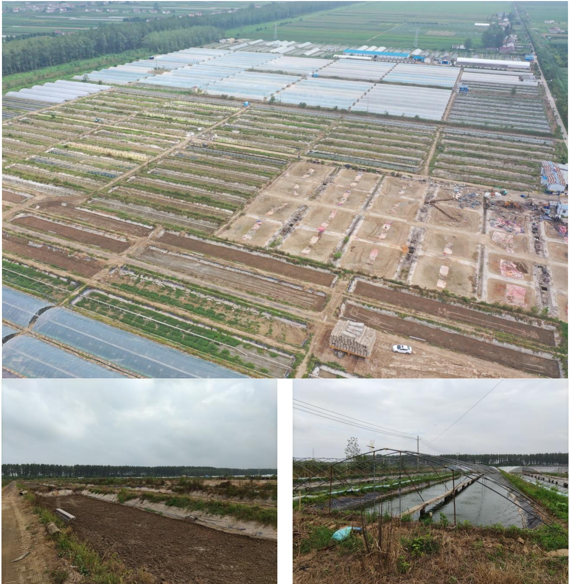
图 3.1-1 丰海 500kV 变电站站区现状
