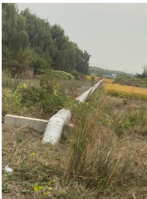
图 1-1 本项目沿线现状实景照片
