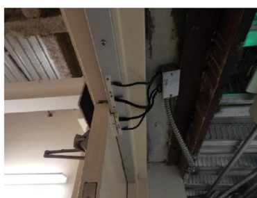
维修室房间门
