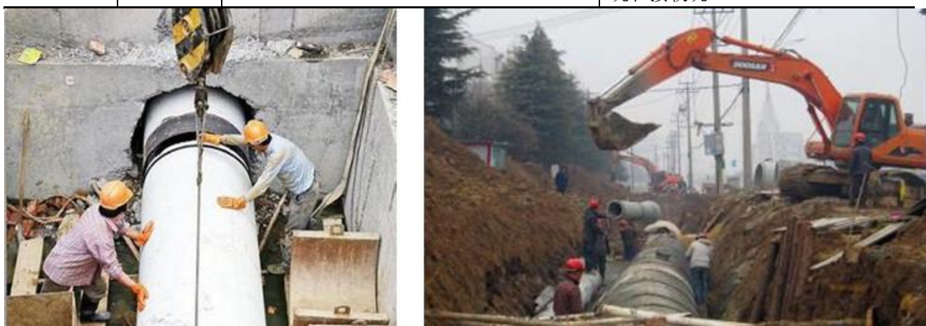
图 4.2-35 顶管施工与开挖施工图
