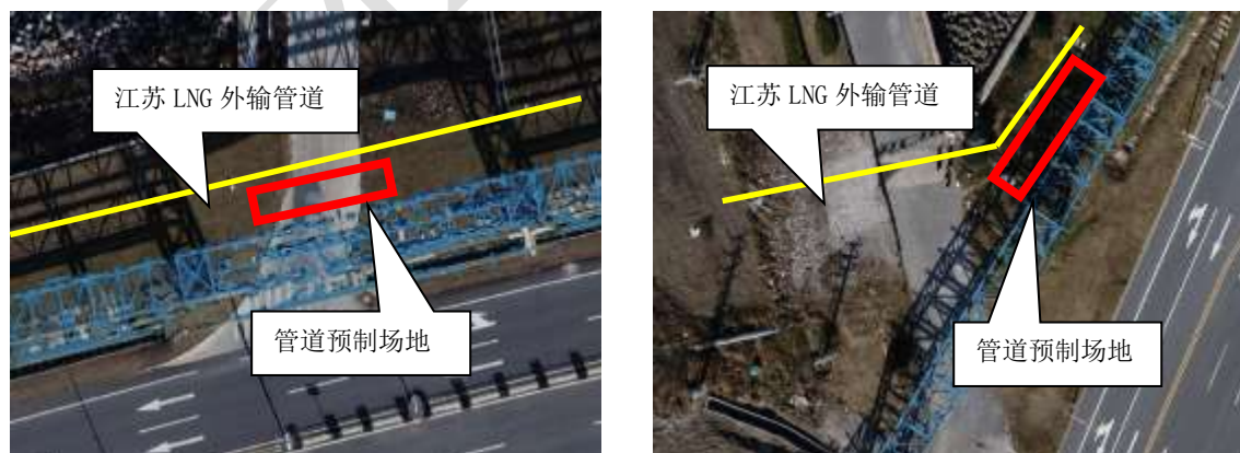
图 3.3.1-9 管线桥之前和之后海堤段管道预制场地
