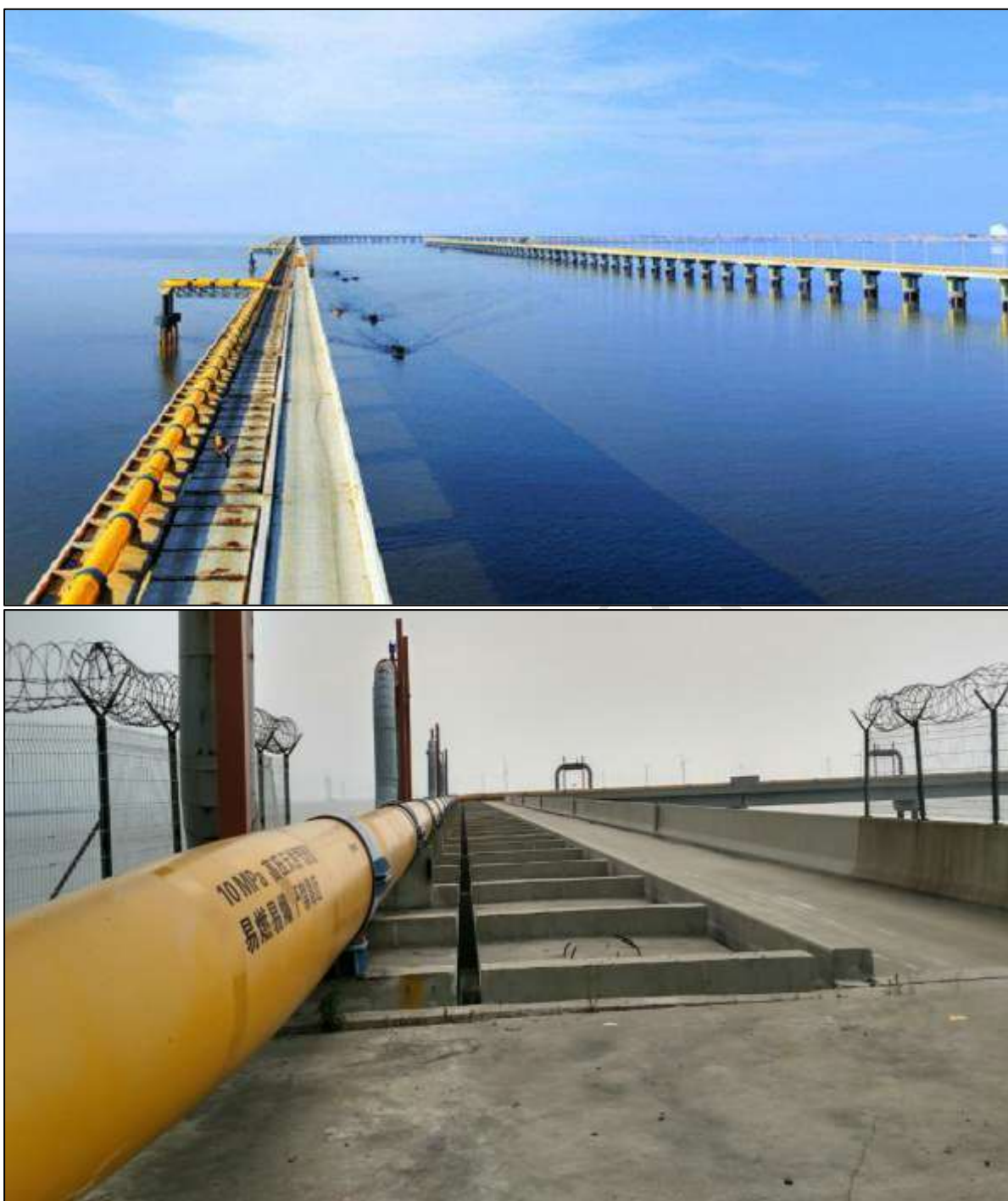
图 3.2.8-1 南通港洋口港区陆岛通道管线桥现状图
