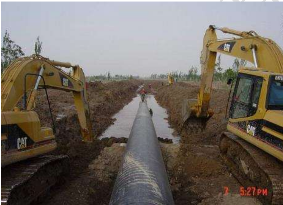
图 3.3.1-4 沉管施工现场图
