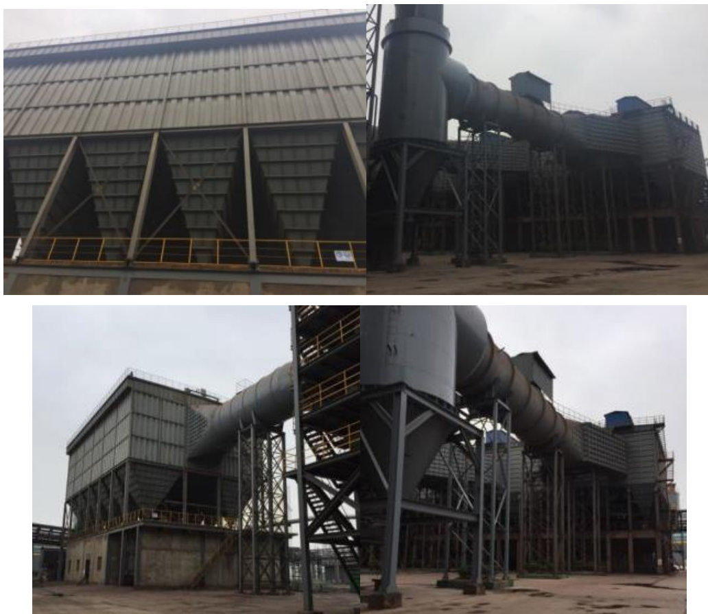
图 7.1-3 脉冲布袋除尘器
